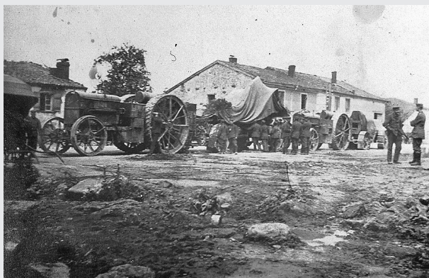
Fig. 63. Transport d'un canon de 420 M-Gerät (40 T) par deux tracteurs Daimler. Usines Krupp. Coll.privée..
