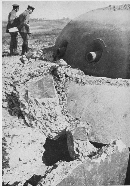
Ein zerstörter Panzerturm
