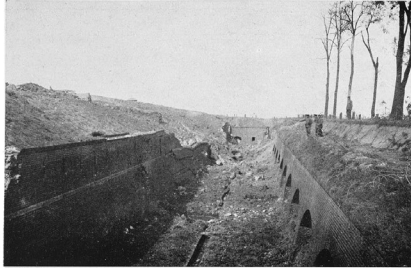
Der äußere Wallgraben
