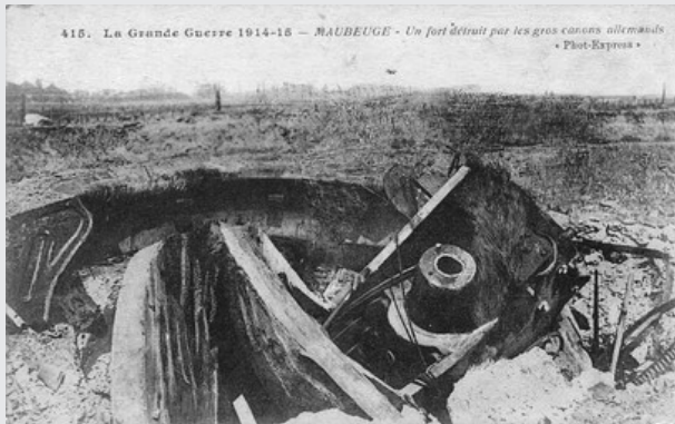
Fig. 59. Destruction d'une tourelle d'un fort avec le canon.
