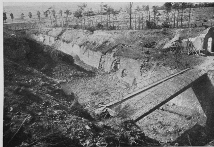
Der äußere Wallgraben
